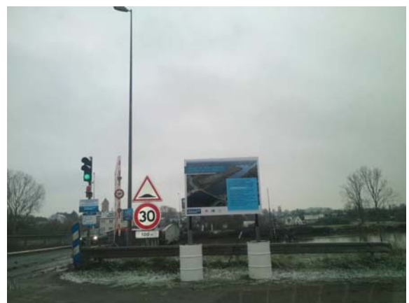
Panneau en rive droite du pont
